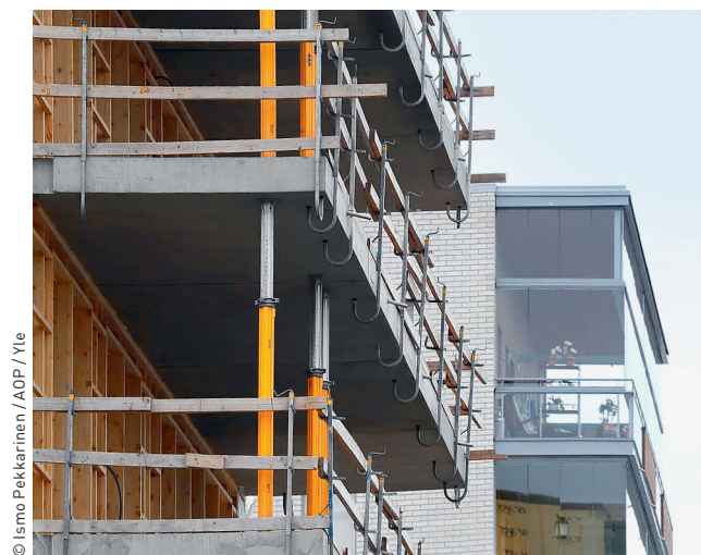
Внешняя стена и балконы из монолитного железобетона
